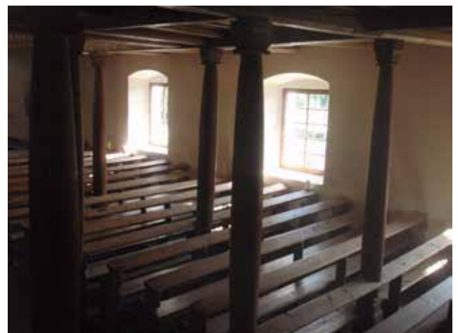
unten: Die alten Bänke und die mächtigen Stützen, die die Empore tragen
